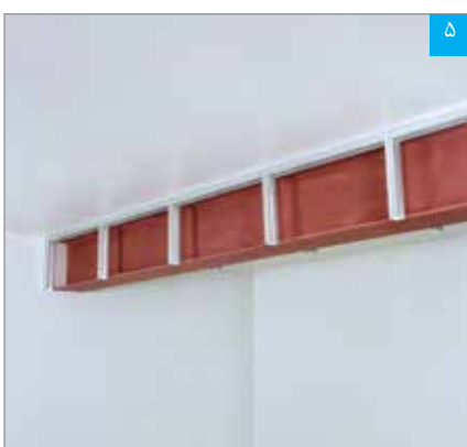
سازه‌های فوقانی و قائم تکمیل شده
