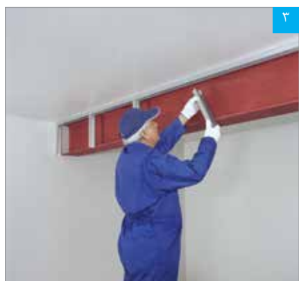
اجرای سازه‌های قائم
