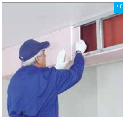
اتصال پنل پشت بند درز به پنل جانبی
