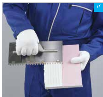
اجرای بتونه درزگیر بر روی نیمی از پنل پشت بند درز (با استفاده از مالنه دندانه‌دار)
