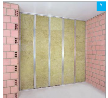
لایه عایق تکمیل شده
