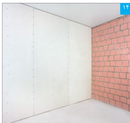
لایه اول پنل‌ها تکمیل شده (دیوار پوششی W625.ir)
