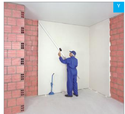
۷ نصب و تنظیم پنل، با پنل نصب شده مجاور
