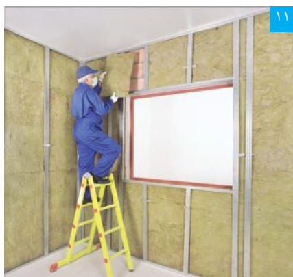
۱۱ اجرای عایق پشم‌معدنی
