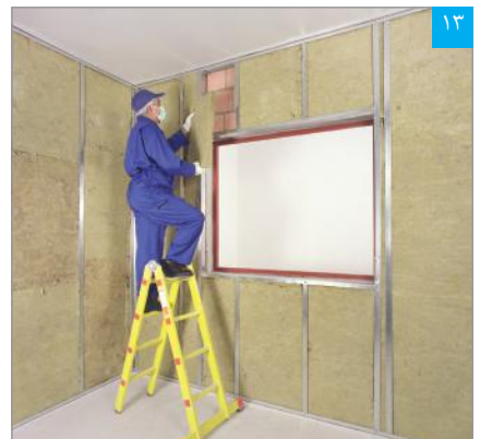
اجرای عایق پشم معدنی
