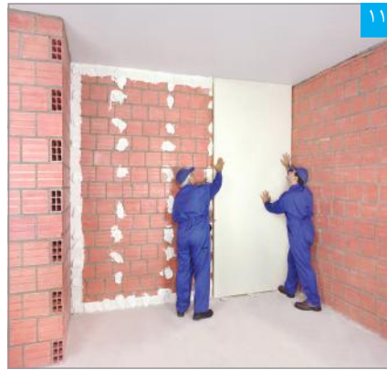
۱۱ استقرار پنل بر روی دیوار زمینه
