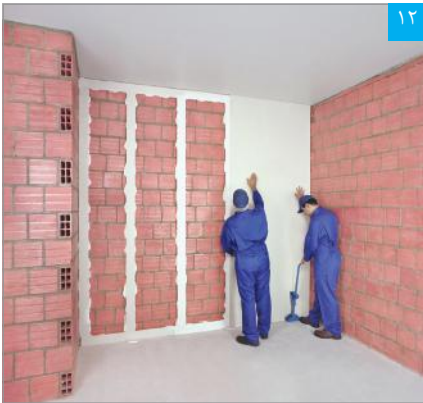
نصب پنل با استفاده از جک نگهدارنده
