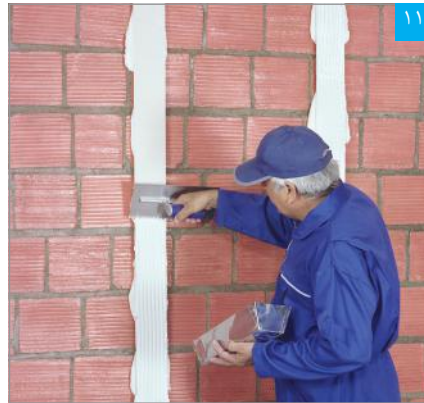
اجرای لایه بتونه درزگیر بر روی کرم‌ها با استفاده از ماله دندانه دار
