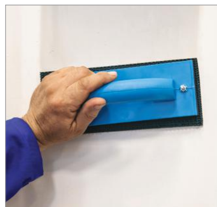
مرطوب کردن سطح دیوار با اسفنج نمدار
