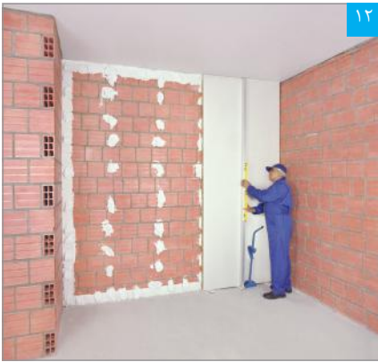
۱۰ بررسی تراز و تنظیم بودن پنل نصب شده با استفاده از شمشه و تراز
