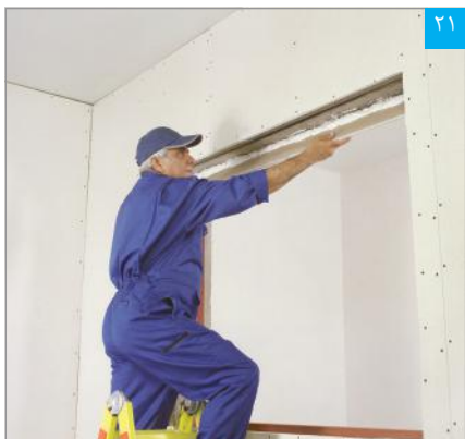
۲۱ استقرار پنل نواری در ناحیه داخلی دور بازشوی پنجره
