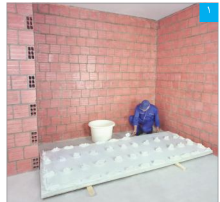
۱ اجرای چانه‌های چسب گچی پنل (بوردفیکس) بر پشت پنل مرکب PS
