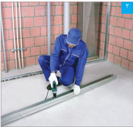
اجرای استادهای دوتایی
