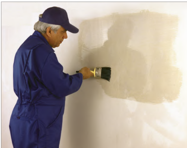
اجرای لایه پرایمر بر روی ماستیک قبل از رنگ‌آمیزی با رنگ روغنی
