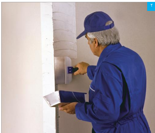
اجرای بتونه روی سازه محافظ گوشه
