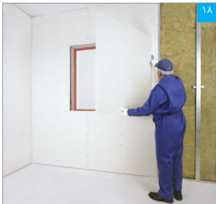
۱۸ برش پنل به صورت «C» شکل (با استفاده از تیغ برش)
