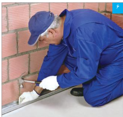
نصب رانر کف
