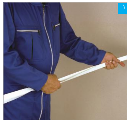
۱ خم کردن نوار درزگیر با دست
