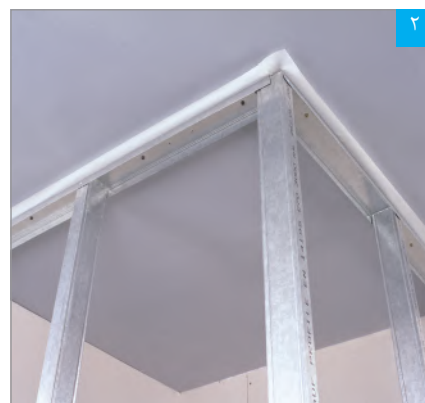
۲ شکستن نوار چسب جداکننده پس از نصب سازه‌ها
