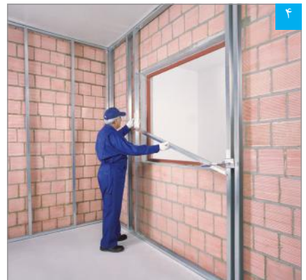
استقرار رانر قاب‌بندی تحتانی (به جهت خم‌ها توجه شود)
