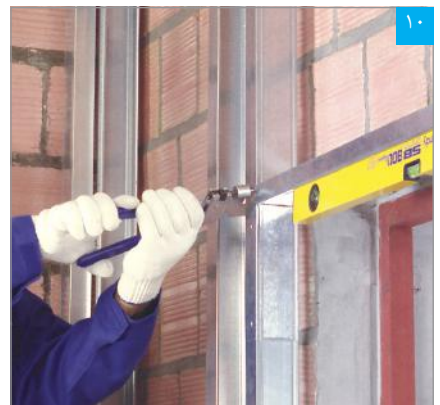
اتصال رانر قاب‌بندی فوقانی به استاد به وسیله پانچ، پرچ یا پیچ (به جهت برش ۴۵ درجه توجه شود)
