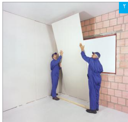
استقرار پنل بر روی دیوار زمینه
