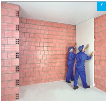
۳ استقرار پنل بر روی دیوار زمینه
