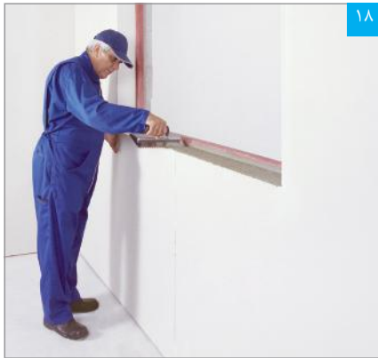
۱۸ اجرای چسب کاشی بر روی سطح پرایمر خورده
