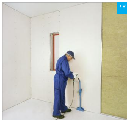
۱۷ نصب پنل بر روی زیرسازی
