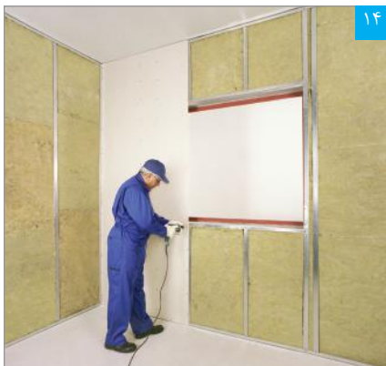
نصب پنل بر روی زیرسازی
