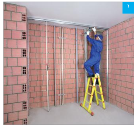
اجرای قاب پیرامونی (به روش مشابه ساختار W625.ir)
