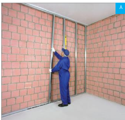
اجرای استاداها (به صورت شاقولی)
