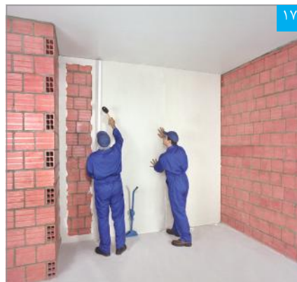
تنظیم نهایی پنل نصب شده با شمشه و چکش لاستیکی
