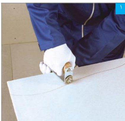
اجرای برش موج‌دار با دستگاه برش قرقراهی
