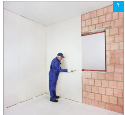
۴ برش پنل با استفاده از اره
