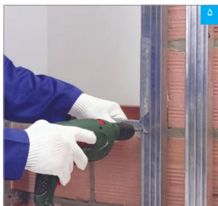
۵ اتصال سازه قاببندی به سازه قائم به وسیله پرچ یا پیچ (به جهت برش ۴۵ درجه توجه شود)
