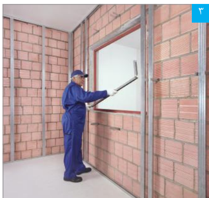
۳ استقرار سازه قاببندی تحتانی (به جهت خم‌ها توجه شود)
