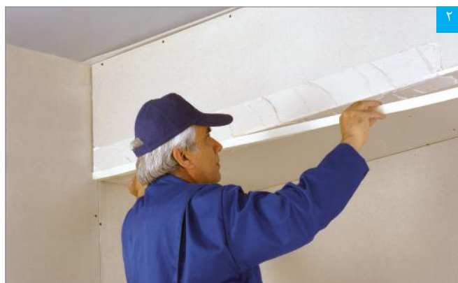
قرار دادن نوار درزگیر بر روی بتونه
