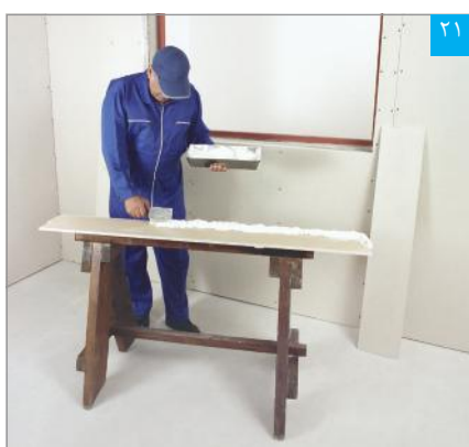
۲۱ اجرای چسب گچی پنل (بوردفیکس) بر پشت پنل نواری (به اجرای یکپارچه چسب گچی پنل توجه شود)
