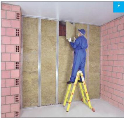
اجرای عایق پشم معدنی (توجه: در فاصله میان استاداها)
