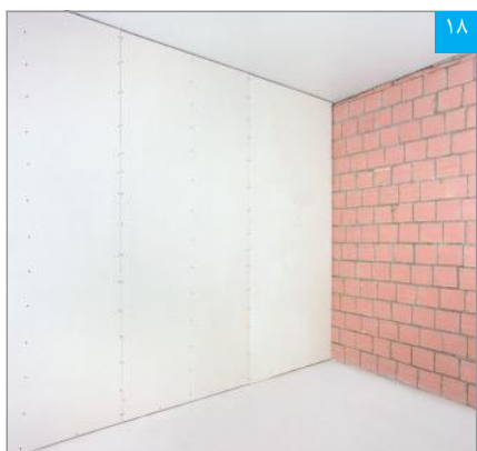
دیوار پوششی تکمیل شده
