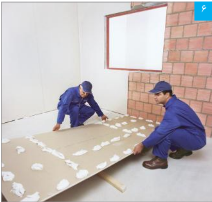
۶ به نحوه اجرای چسب گچی پنل (بوردفیکس) در محل بازشوی پنجره توجه شود
