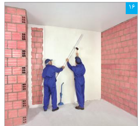
نصب و تنظیم پنل، با پنل نصب شده مجاور
