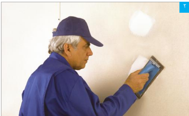
پرداخت سطح بتونه خشک
