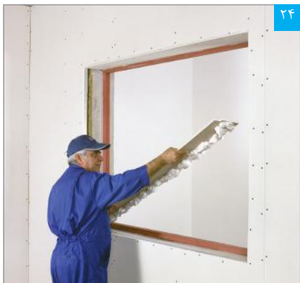
۲۴ استقرار پنل نواری در ناحیه داخلی دور بازشوی پنجره
