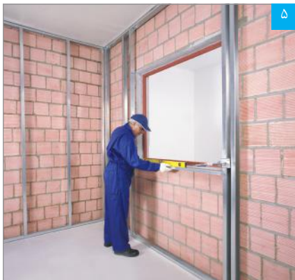
تنظیم رانر قاب‌بندی تحتانی به وسیله تراز
