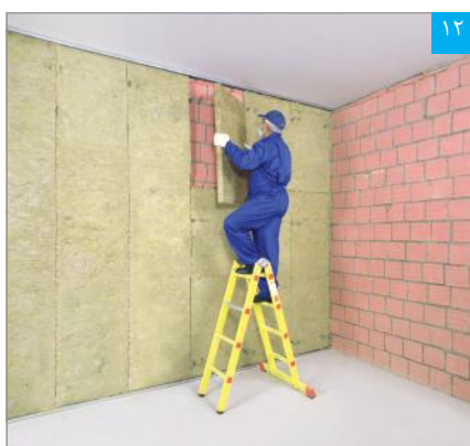
۱۲ اجرای عایق پشم معدنی
