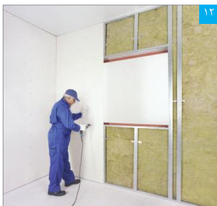
۱۲ نصب پنل بر روی زیرسازی
