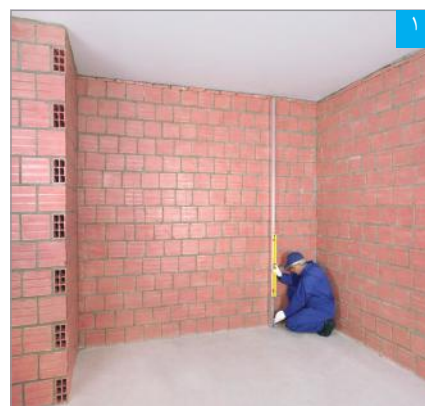
شمشه‌گذاری بر روی دیوار زمینه، جهت تعیین ناترازی آن و علامت‌گذاری روی کف
