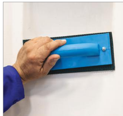
مرطوب کردن سطح دیوار با اسفنج نمدار
