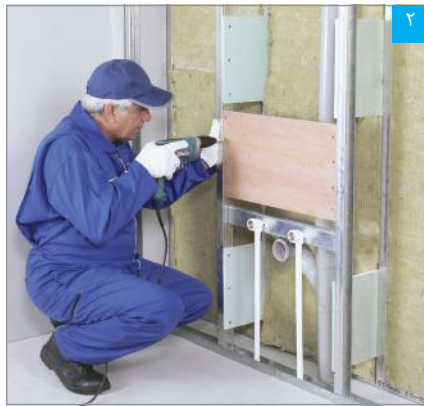
اتصال تراورس (تخته چند لایی) به قطعات نبشی L25
