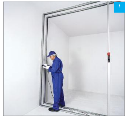
دو ردیف قاب با فاصله از یکدیگر اجرا می‌شوند (فاصله قاب‌ها به حجم تاسیسات بستگی دارد)
