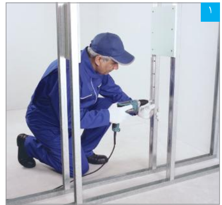
اتصال قطعات نبشی L25 به استادهای مجاور
