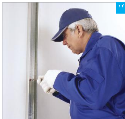
اتصال استادا به دیوار بنایی با رول پلاگ
