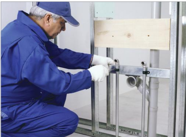
اتصال لوله‌های تاسیساتی به سازه پشتیبان SP60
