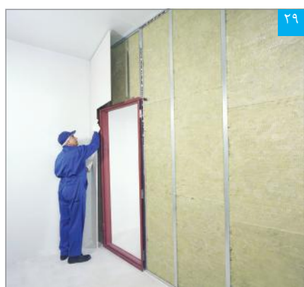
۲۹ اجرای پنل سوم دور چهارچوب پس از عایق‌گذاری (پنل‌ها نسبت به سمت اول بصورت حصیرچین اجرا می‌شوند)
