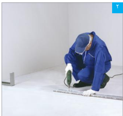
نصب رانر کف
