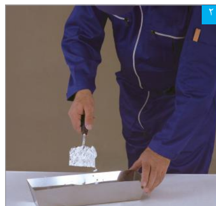
ریختن پودر بتونه در آب
