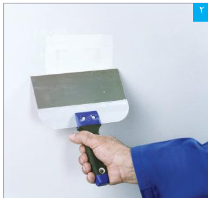
اجرای بتونه بر روی وصله ترمیمی
