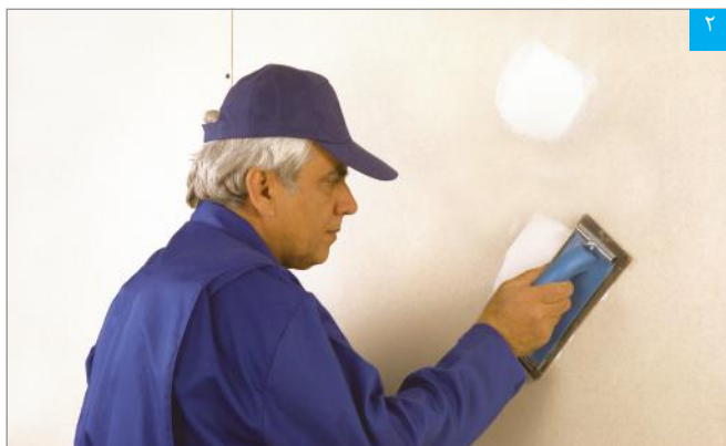
پرداخت سطح بتونه خشک
