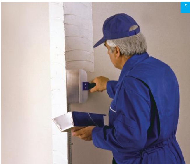
اجرای بتونه روی سازه محافظ گوشه
