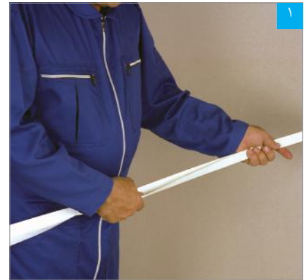
خم کردن نوار درزگیر با دست
